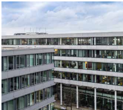
Werinherstrasse 79/81/91 - Munich, Allemagne
